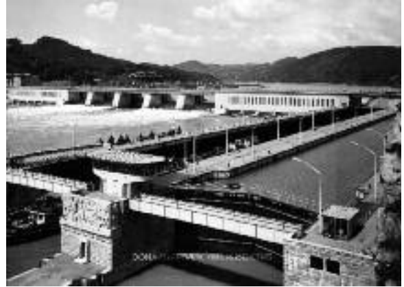
Nibelungen-Fries an der Schleuseneinfahrt
